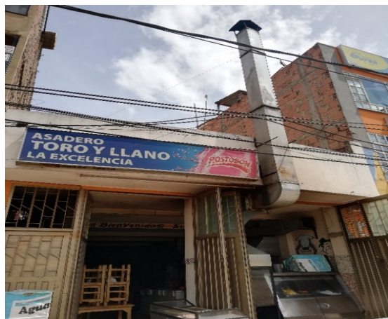
FOTOGRAFIA No 1. FACHADA DEL PREDIO
